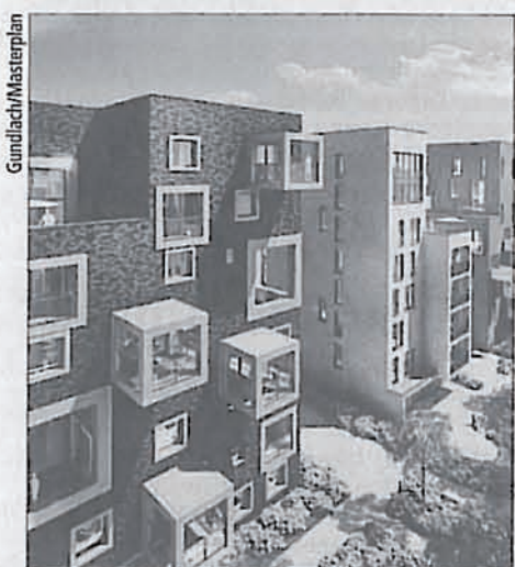
PELIKANVIERTEL / VIER: Vier Architekten bauen für das hannoversche Unternehmen Gundlach im Lister Pelikanviertel vier Quartiere für völlig unterschiedliche Lebensstile: komfortabel, entspannt, nachhaltig, extravagant. Der Bau läuft bereits seit einem Jahr, unterm Strich entstehen 166 Miet- und Eigentumswohnungen.
